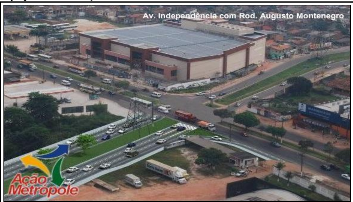
FIGURA 07 – Cruzamento da Av. Independência com a Rod. Augusto Montenegro após os projetos de intervenção.
