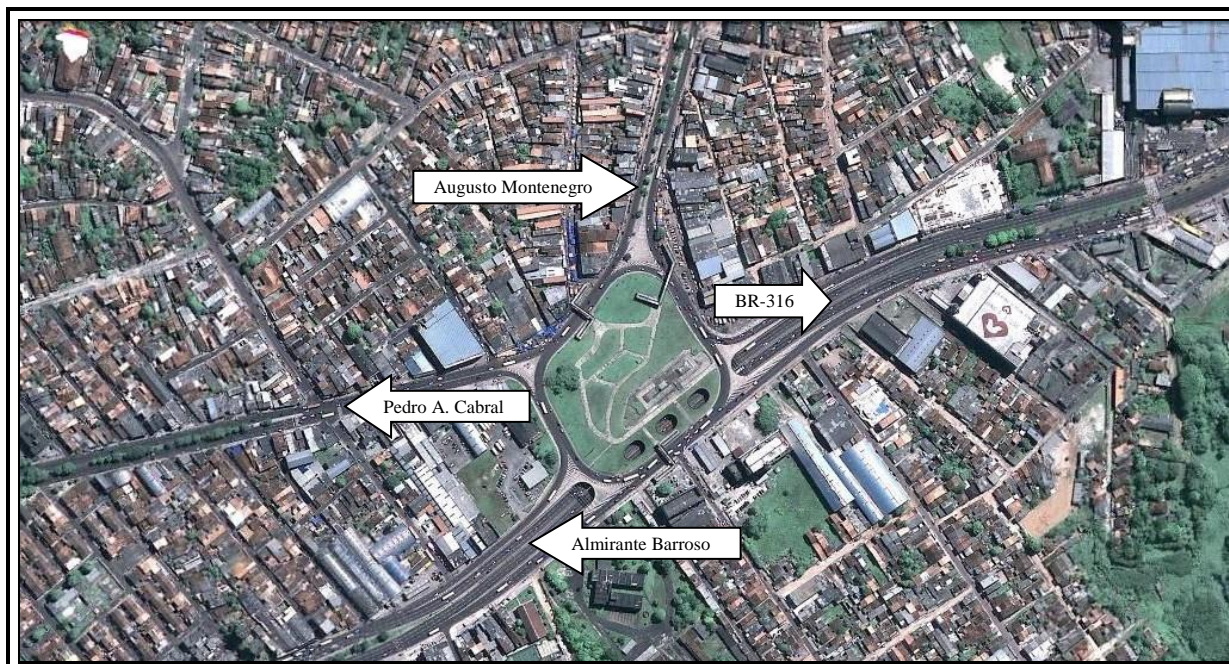
FIGURA 02 – Imagem do complexo viário do entroncamento
